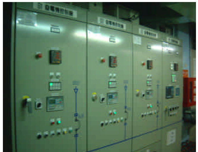
新系統為 ComAp IG-NT 數位式發電機並聯盤
